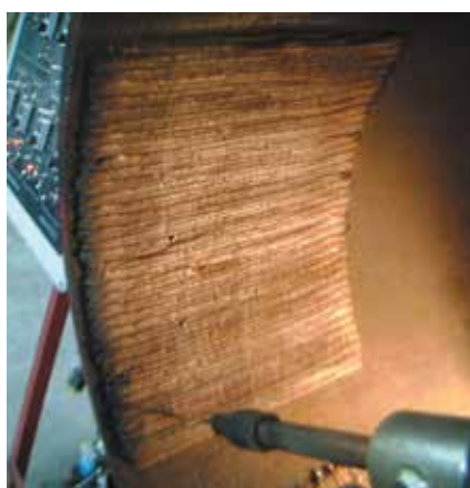
Горизонтальная облицовка внутреннего диаметра труб с помощью Stody CP-2000
