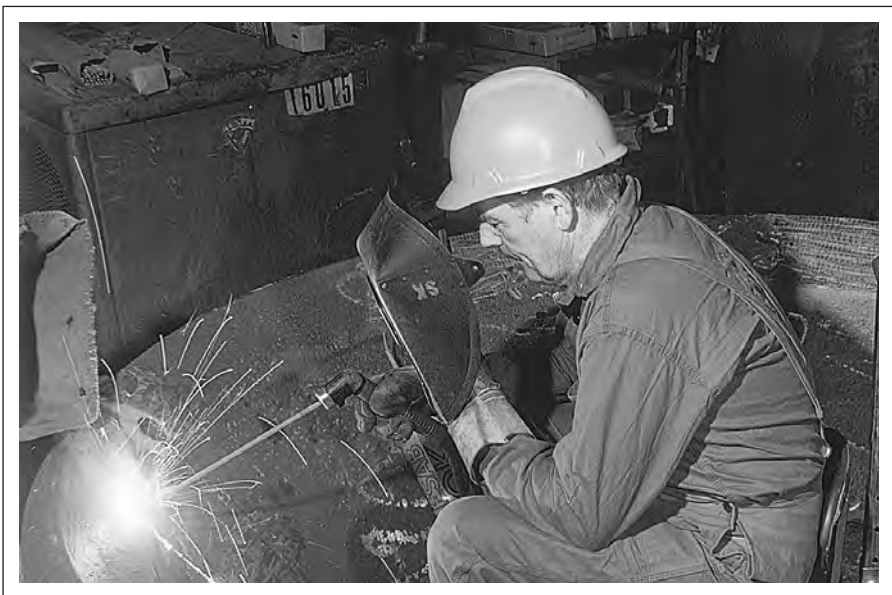
Ремонт дробилки из стали Гадфильда с помощью электродов OK 86.08 .
