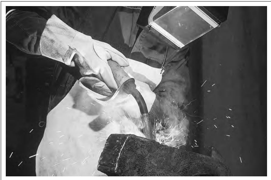
Восстановление рабочей поверхности бил с помощью проволоки ОК Tubrodur 15.65.
