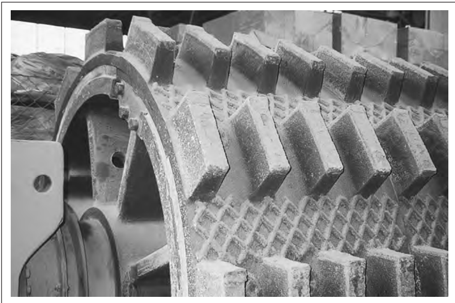
Изношенные зубья дробильного барабана, наплавленные электродами ОК 86.20 и упрочненные электродами ОК 84.78 и проволокой ОК Tubrodur 14.70.
