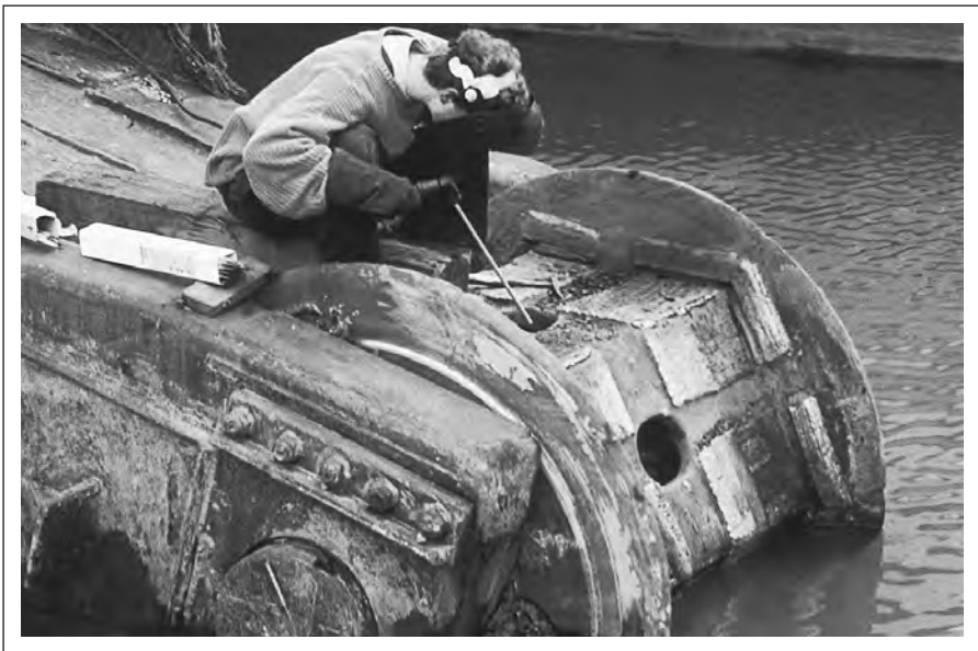
Восстановление барабана электродами OK 83.28 с последующей упрочняющей наплавкой электродами OK 84.84 .
