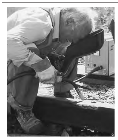
Наплавка головки рельса проволокой OK Tubrodur 15.43
