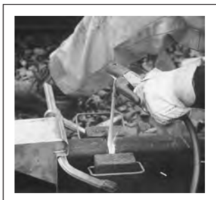
Сварка стыков рельсов электродами OK 74.78
