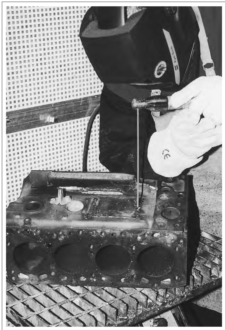
Ремонт чугунного блока двигателя автомобиля электродами ОК 92.18 и ОК 92.60
