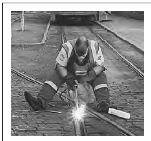
Ремонт трамвайных линий электродами OK 67.52
