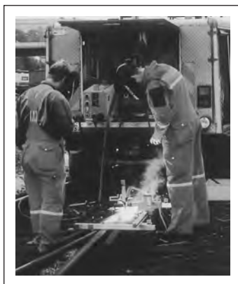
Механизированная наплавка рельсов и крестовин с помощью установки Railtrac BV проволокой Tubrodur 15.43
