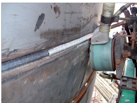
Образец сварного шва, полученного при использовании установки AGW-II
