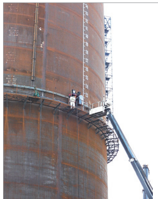
Установка AGW-P на строительной площадке
